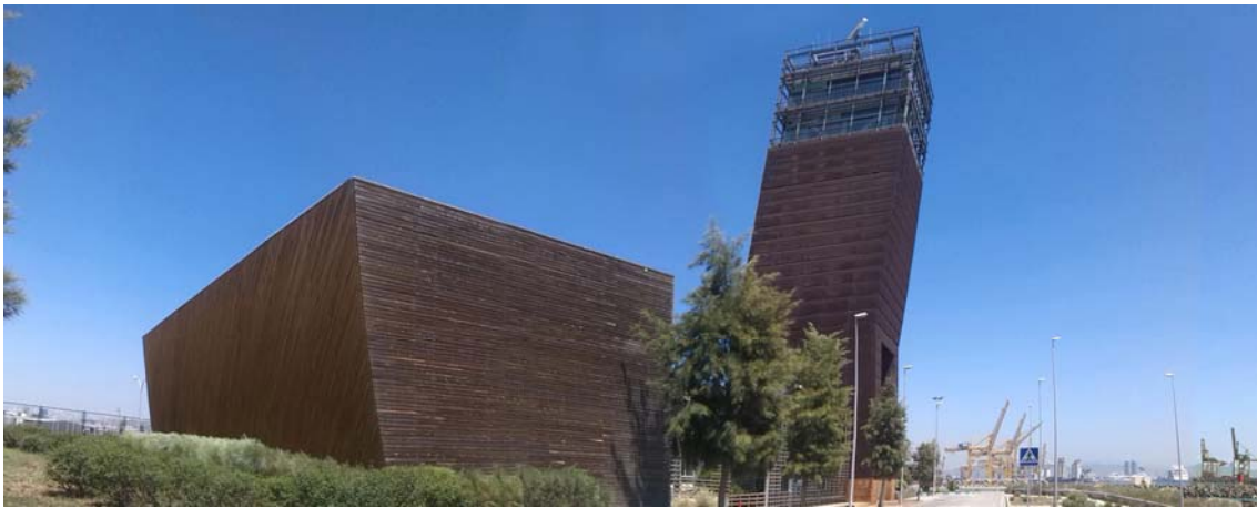
Torre de Control del Port de Barcelona (España), Josep Botey.
